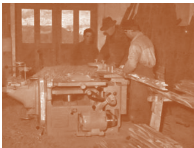
Na carpintaria, o irmão-chefe da oficina executa com todo o rigor, em máquinas que são a última palavra da técnica, o trabalho de madeira para o novo Seminário em construção.
